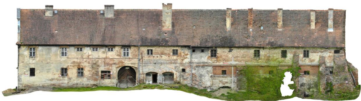
Ryc. 3 Widok elewacji północnej
