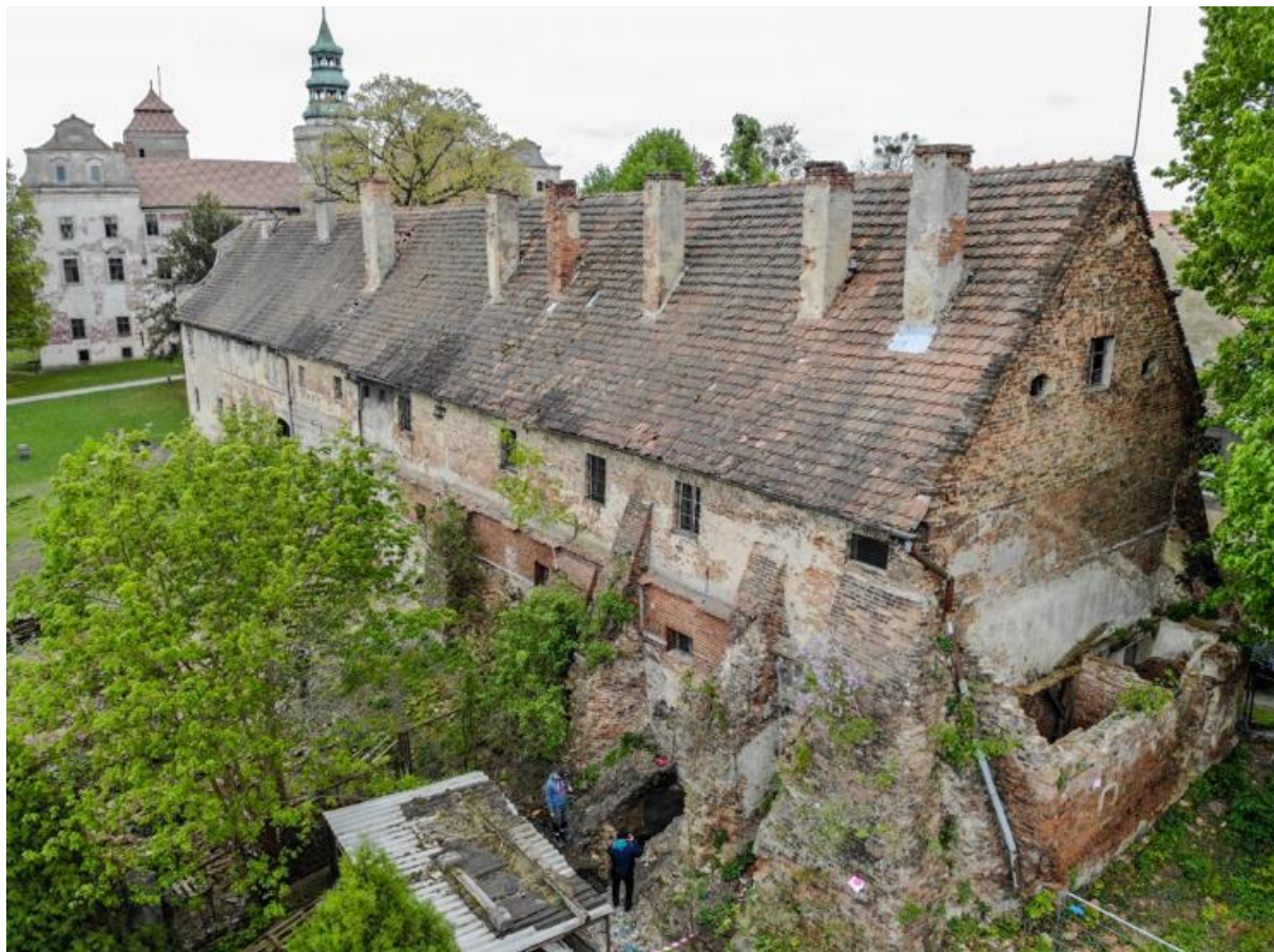
Ryc. 2 Widok ogólny oficyny zamkowej
